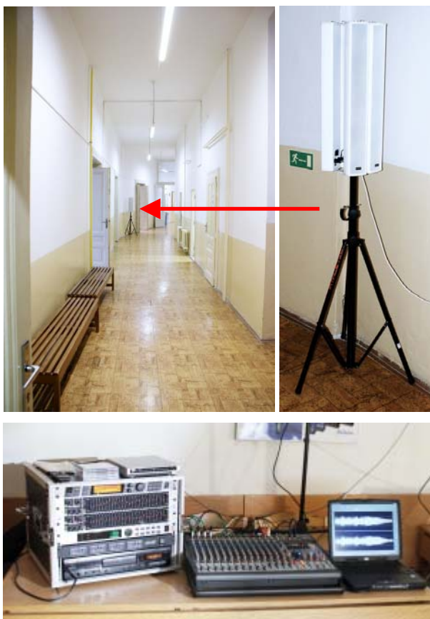
Obr.213 Koridor KTP, ozvučovací systém se stěnami 2×DPT208, řídicí pracoviště
