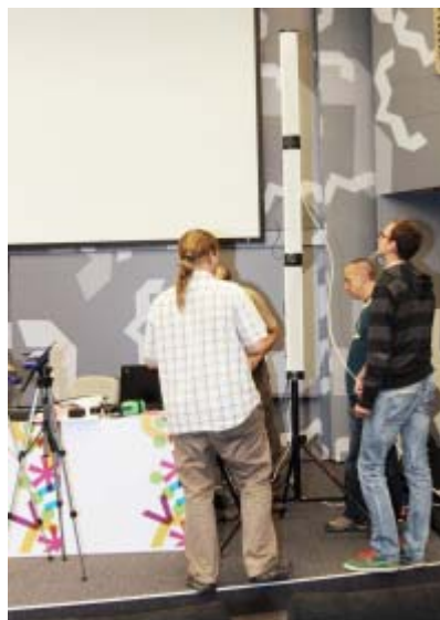
Obr.232 Instalace 2m reproduktorového sloupu na pódiu auly OSV
