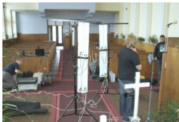
Obr.234 Montáž skládaných zářičů 2 × 16 v Husově sboru
