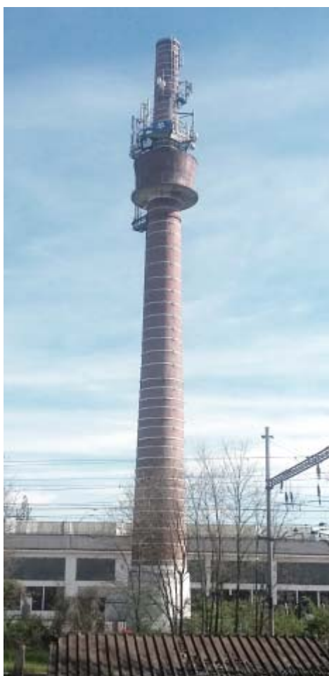
Obr.4 Komínový vodojem - Přelouč
