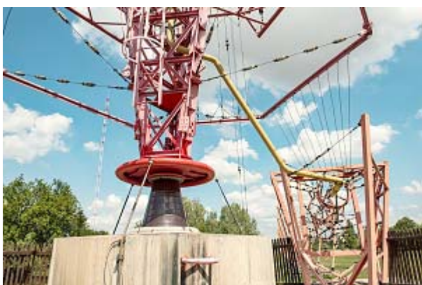
Obr.16 Pata anténního stožáru ARPO s koaxiálním napájecím vedením [3]
