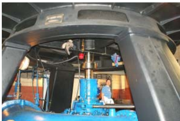
Obr.27 Francisova turbína pod generátorem
