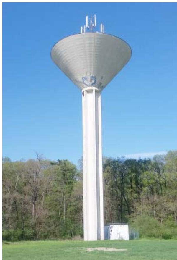
Obr.5 Věžový vodojem s kuželovým tvarem železobetonové nádrže - Městec Králové
