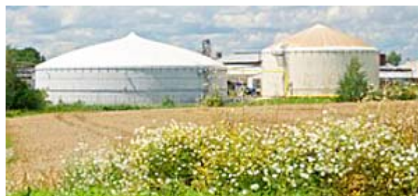
Obr.6 Dohnivací nádrž a fermentor
