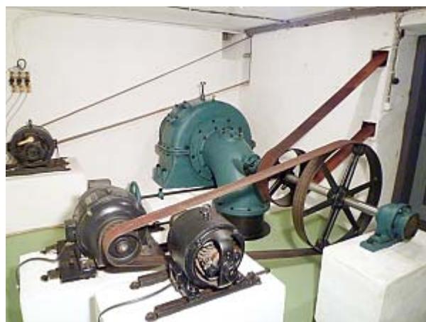
Obr.44 Strojovna vodního mlýna [4]
