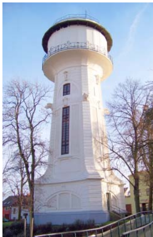
Obr.3 Věžový válcový vodojem - Nymburk [8]
