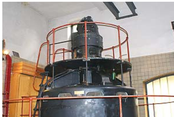
Obr.28 Generátor a budič MVE Myší díra
