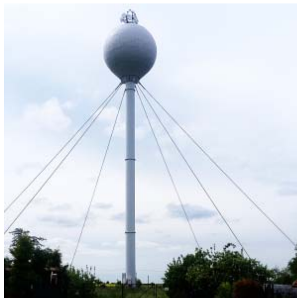
Obr.14 Vodojem ve tvaru koule s fixačními lany - Jestřábí Lhota
