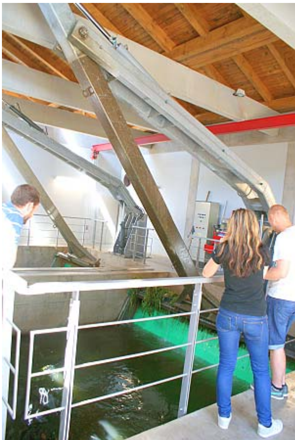
Obr.36 Česlovna MVE Železný Brod
