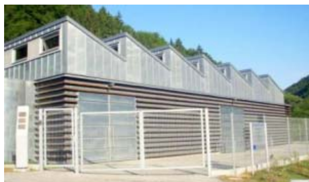
Obr.35 MVE Železný Brod
