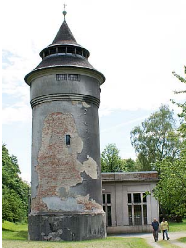
Obr.38 MVE Popelnice - vodní věž
