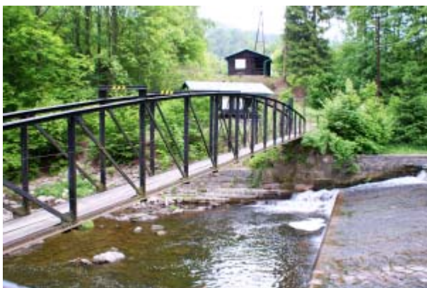
Obr.21 Přístupová lávka k elektrárně
