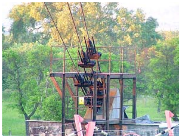
Obr.17 Kotevní blok anténního stožáru
