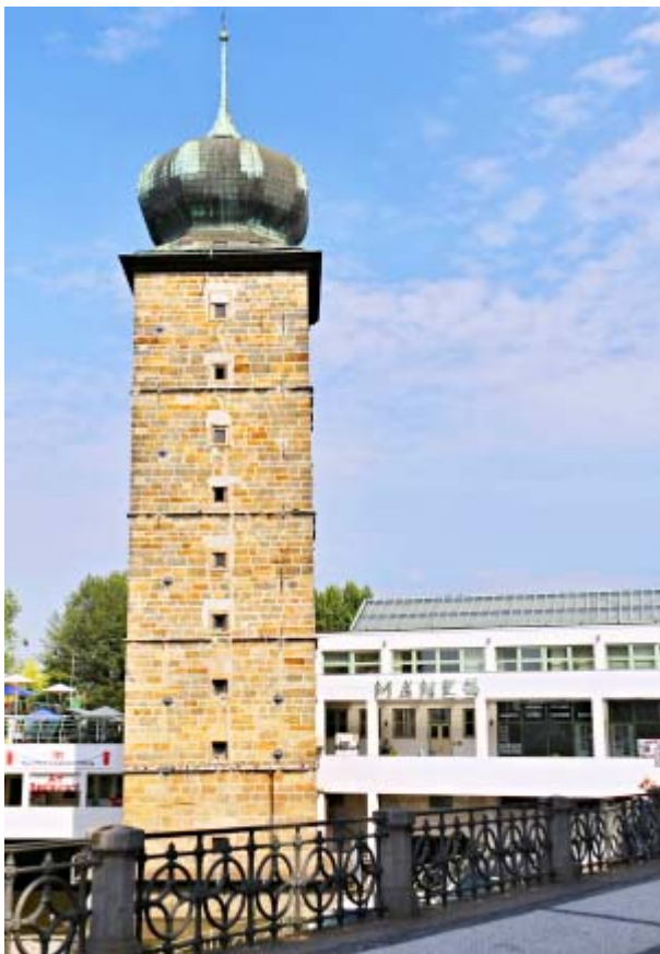
Obr.1 Šítkovská vodárenská věž Praha - Nové město [6]
