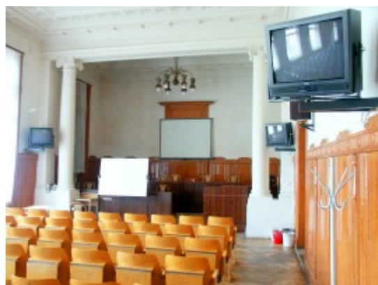
Obr.1 Aula PdF UHK před rekonstrukcí
